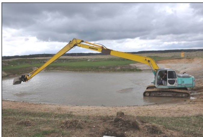
7 pav. Vandens telkinių valymas ilgastreliu ekskavatoriumi
